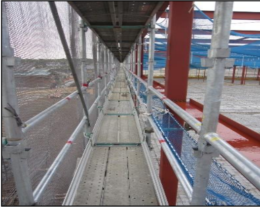
作業通路①
