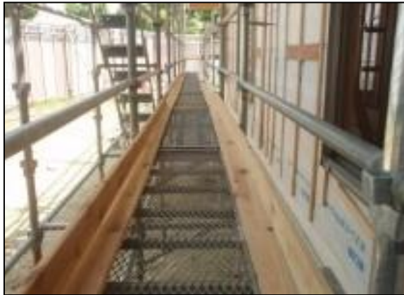
作業通路②
