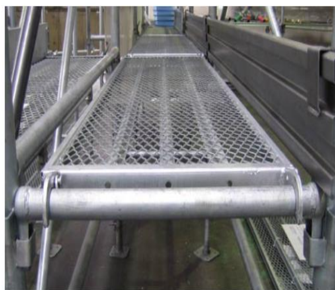
施工イメージ
