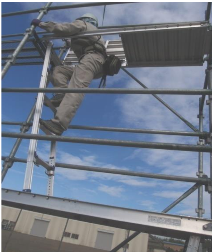
※当社愛知弥富センターにて取付・検証作業を実施
