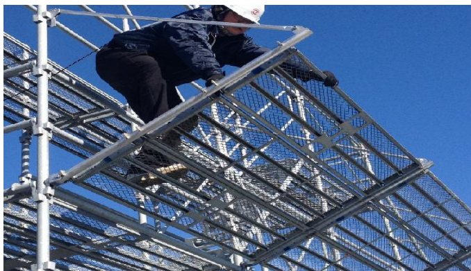
④ 隣接したスパンに同様の手順で取り付け、踏板を手前から設置する
