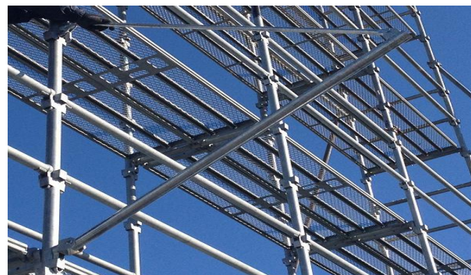
② 下部クサビ取付位置から3コマ上に上部クサビを差し込む
