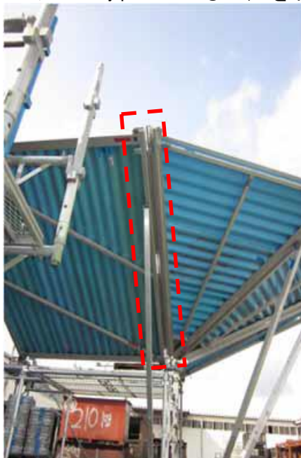
○ フレームに掛かっているコーナーを下から見た状態
